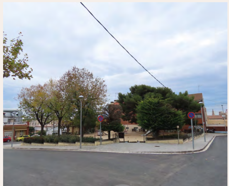
▲ L'actuació s'ha completat amb el reasfaltatge de les calçades del voltant.
