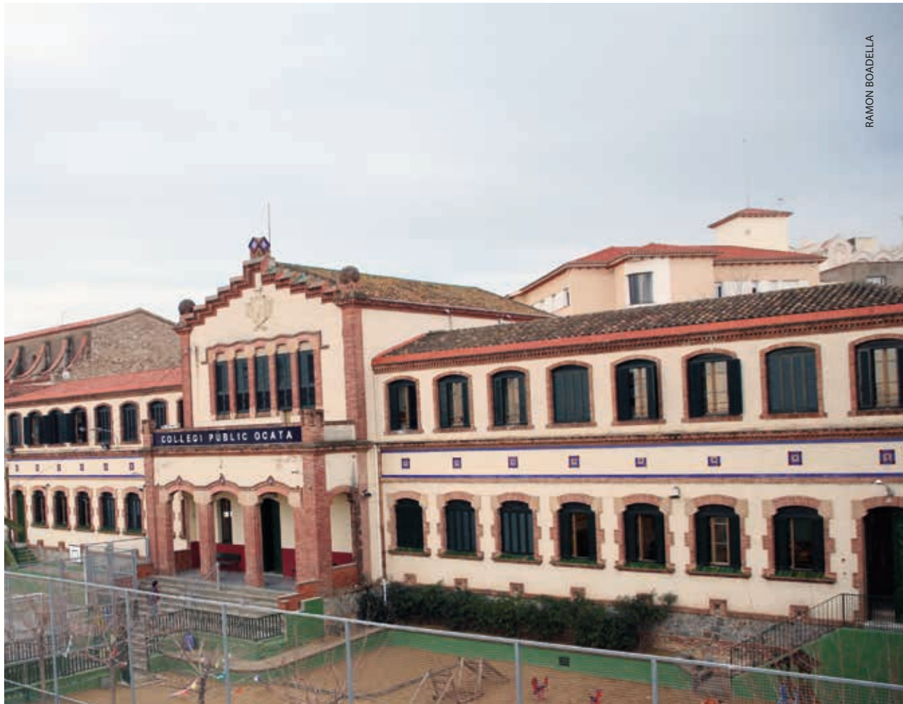
Façana de l'escola Ocata.
