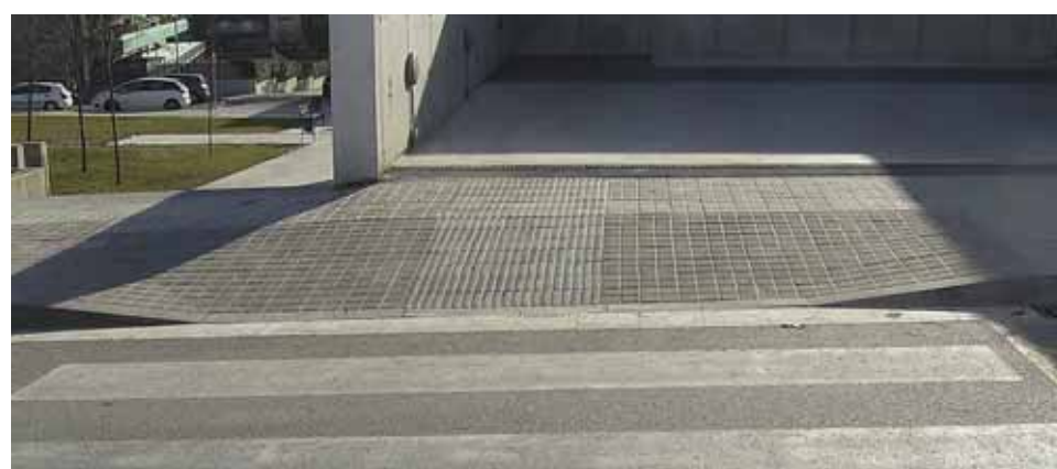
Una de les voreres arranjades que es troba a la sortida del CAP Ocata-Teià.
