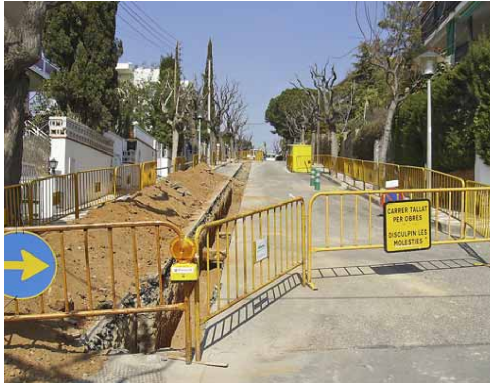
Les obres al carrer de Girona renovaran el clavegueram.
